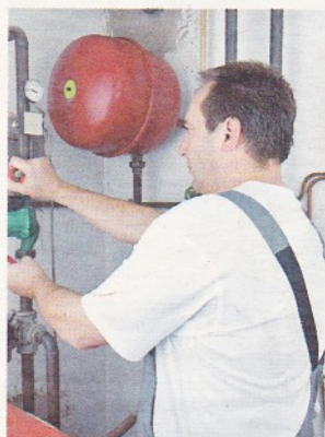
Hilfe kommt vom Installateur.
